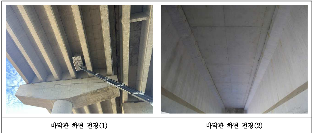
【사진 20.3.27】 바닥판하면 전경
