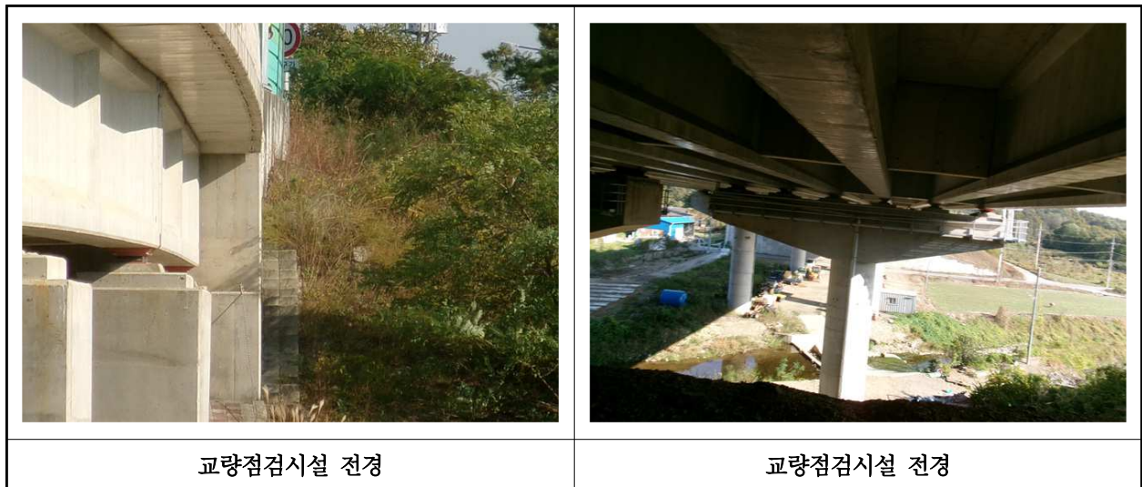
【사진 20.3.50】 교량 점검시설 전경
