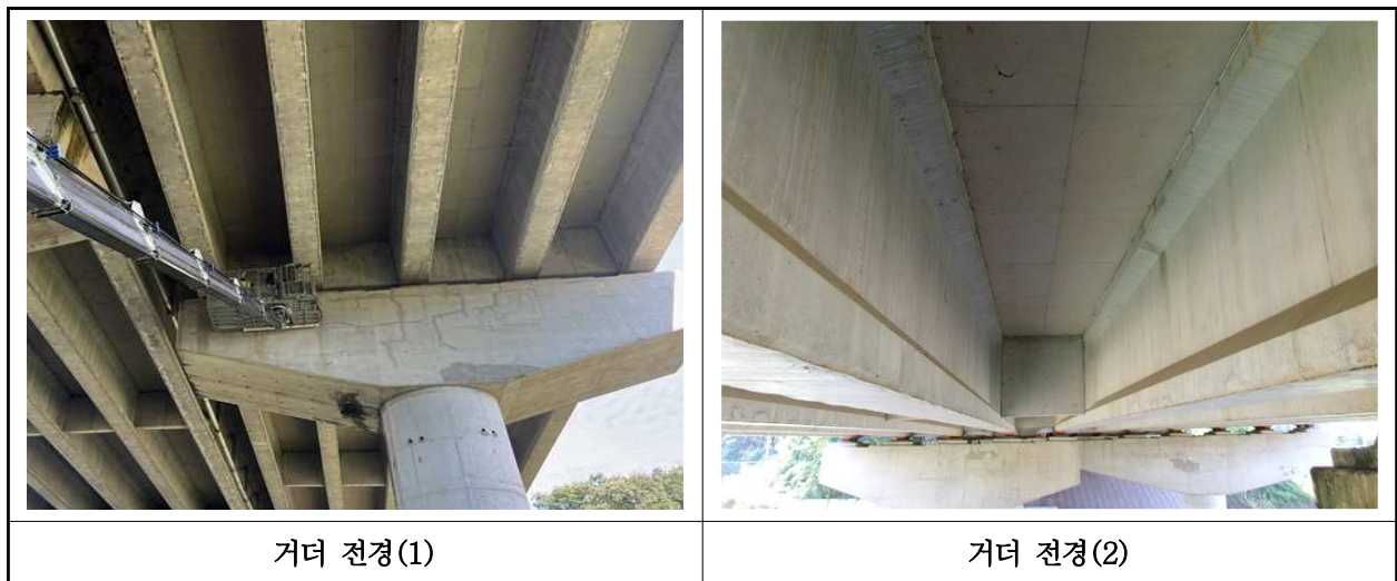
【사진 20.3.4】 거더 전경
