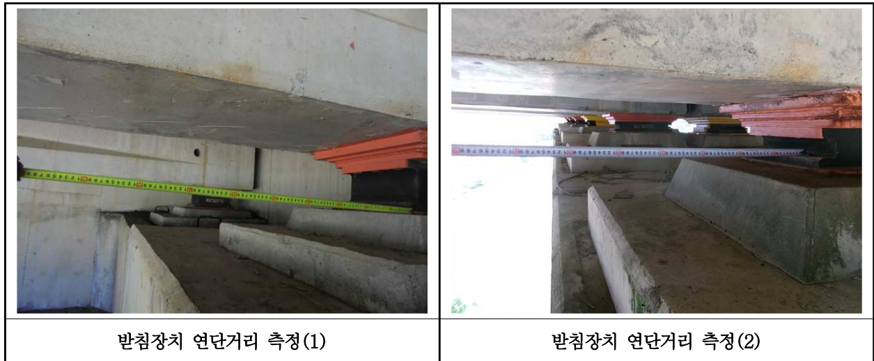
【사진 20.3.39】 교량받침장치 연단거리측정
