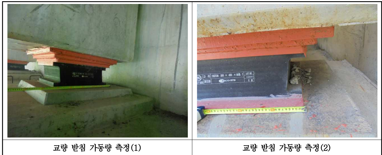
【사진 20.3.40】 교량받침 이동량 측정
