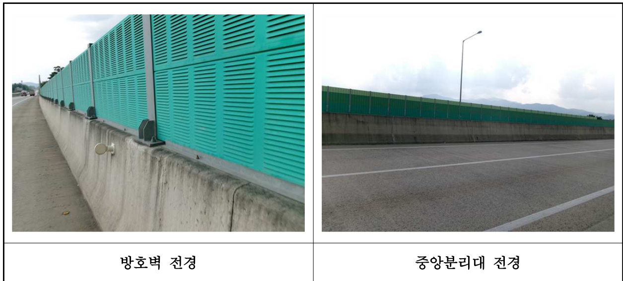
【사진 20.3.23】 방호벽 및 중양분리대 전경
