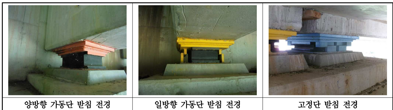
【사진 20.3.37】 교량받침 전경
