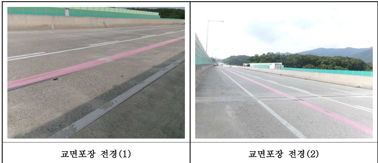
【사진 20.3.44】 교면포장 전경
