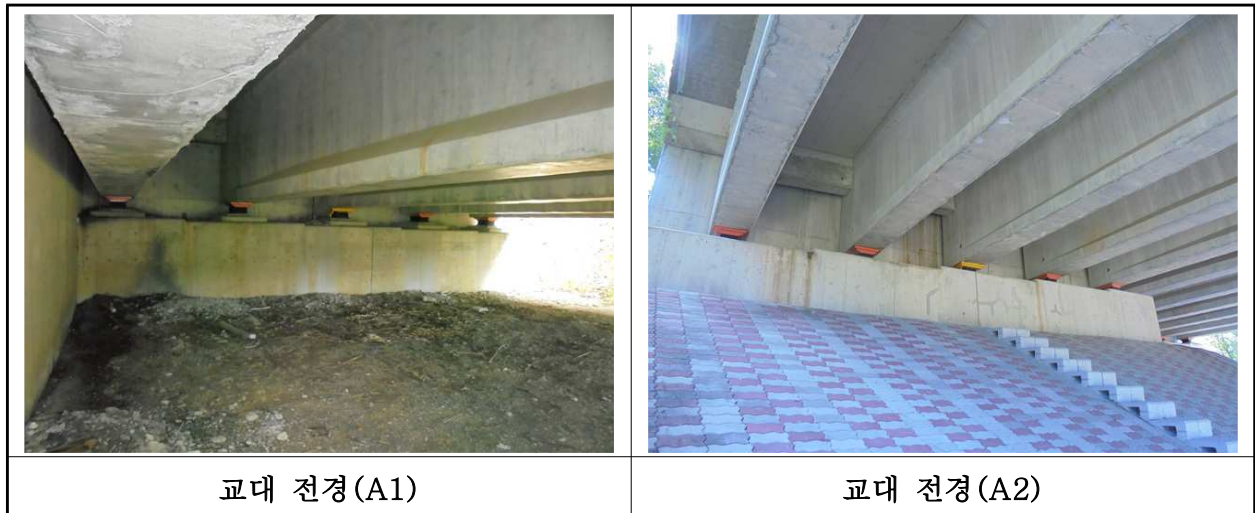
【사진 20.3.8】 교대 전경
